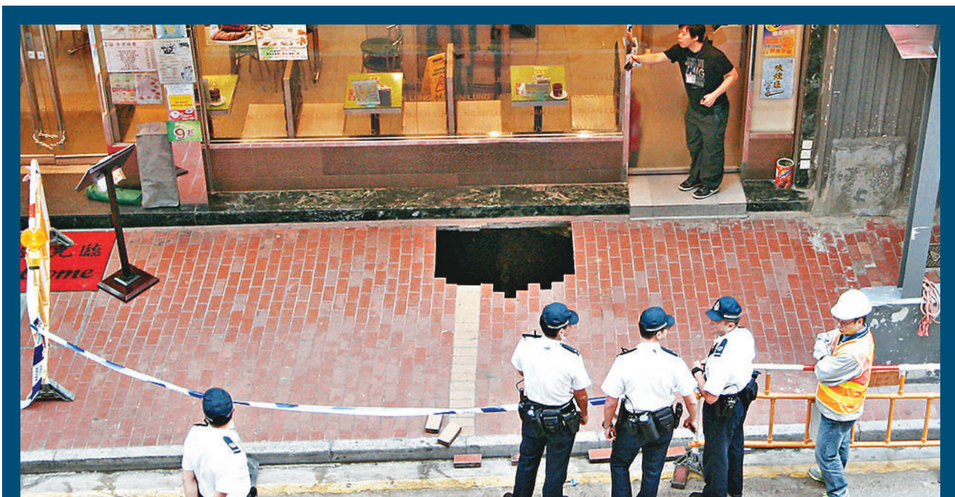
渣甸街發生路陷行人路。
