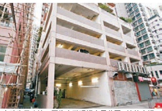
偷竊犯事敗失足墮樓，圖為案發現場南景花園3樓停車場。
