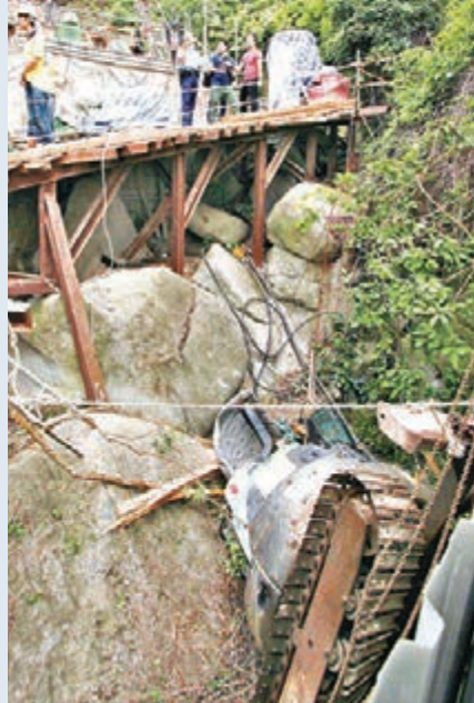
■實雲道斜坡地盤小型挖泥車坡現場。
