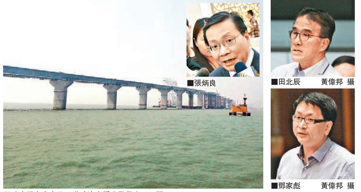
政府發言人表示,港珠澳大橋分階段完工,不影響通車日期。圖為正在加緊建設港珠澳大橋的施工船。
