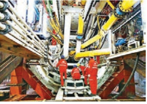
■施工人員在地鐵盾構機內作業。本報蘭州傳真
