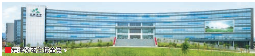
元暉光電主樓全景。
