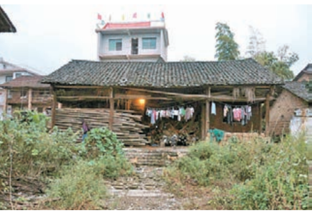
南村草堂僅存的一棟正屋也搖搖欲墜。譚錦屏攝
