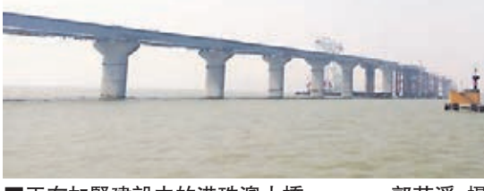
正在加緊建設中的港珠澳大橋。 郭若溪 攝
