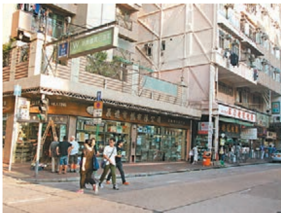
■油麻地上海街貨車輾破通渠水樽現場。
