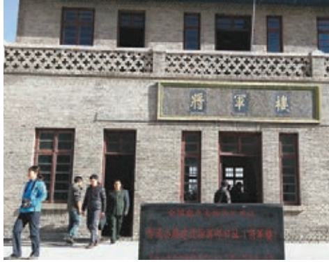
■「青藏公路建設指揮部舊址——將軍樓。」
