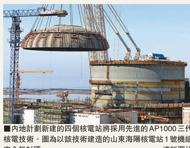
內地計劃新建的四個核電站將採用先進的AP1000三代核電技術。圖為以該技術建造的山東海陽核電站1號機組安全殼封頂。
