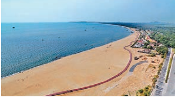
■這是秦皇島市海港区西浴場海灘上新建的木棧道。
