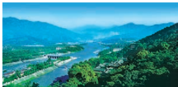
都江堰水利工程。
