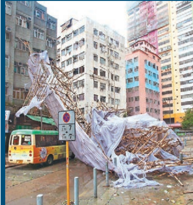
■「海鷗」襲港，打磚坪街發生大面積棚架倒塌，棚下一部小巴被困。
