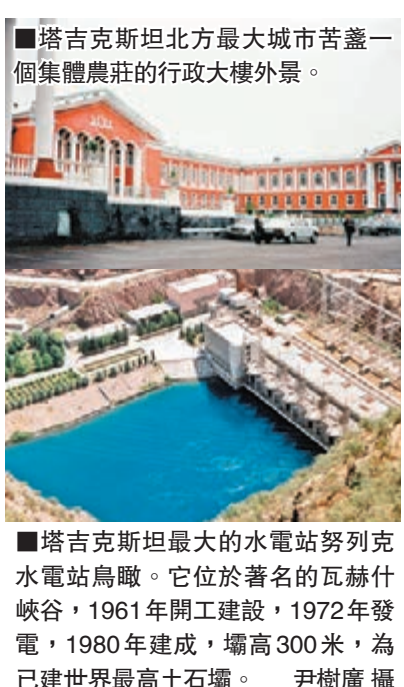
塔吉克斯坦最大的水電站努列克水電站鳥瞰。它位於著名的瓦赫什峽谷，1961年開工建設，1972年發電，1980年建成，壩高300米，為已建世界最高土石壩。 尹樹廣攝
