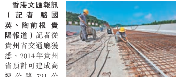
三穗至黎平高速公路八舟河大橋施工現場。本報貴州傳真
