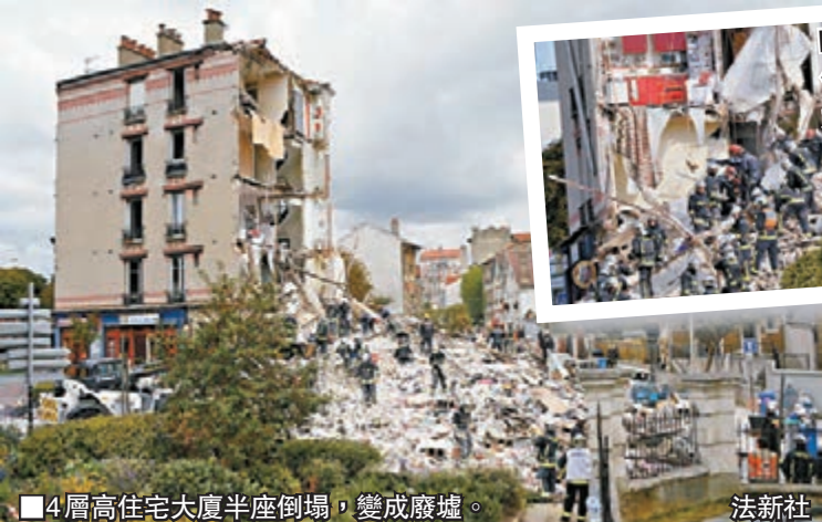
4層高住宅大廈半座倒塌，變成廢墟。
