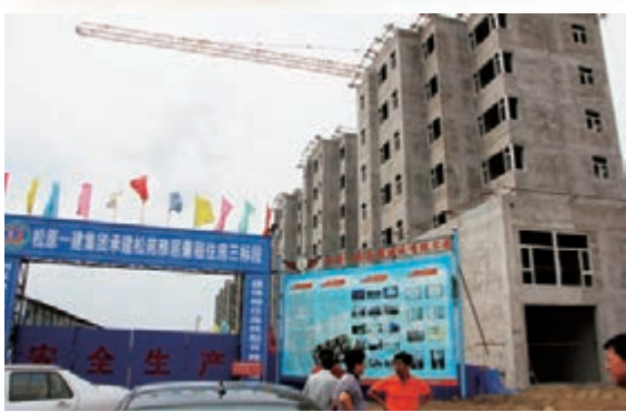
■松苑雅居社區廉租房建設中。
