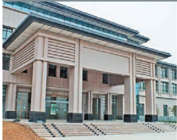
超標縣委辦公樓已竣工。本報武漢傳真
