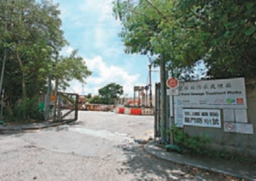
■發生設施故障導致9.5萬立方米污水流出大海的望后石污水處理廠。
