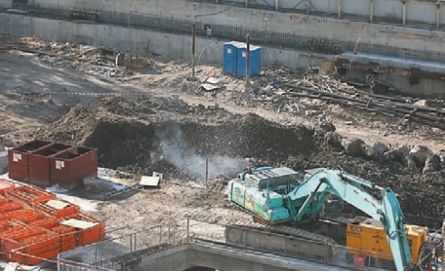
▲北角渣華道地盤有戰前炸彈出土，專家堆起沙包第一度引爆時出現飛沙走石。
