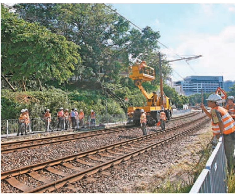
工程人員在清理塌樹後，緊急搶修受損架空電纜。
