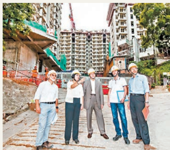
張炳良(中)視察蘇屋邨重建地盤。
