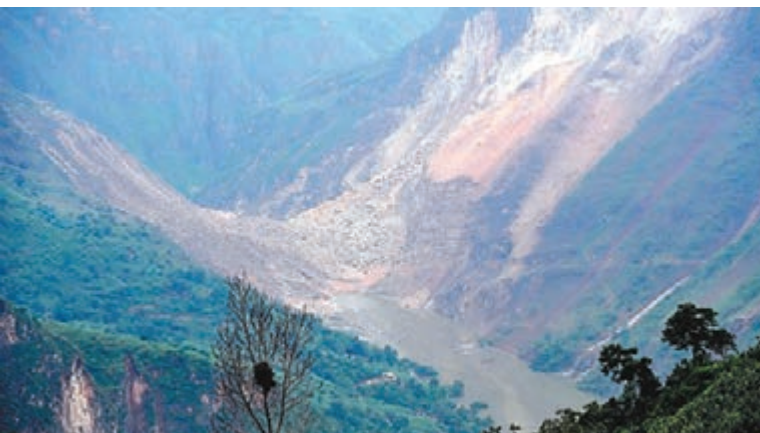
魯甸地震造成牛欄江一個電站取水壩處山體塌方，形成堰塞湖，庫區被淹40餘戶，200餘人已經轉移。中新社
