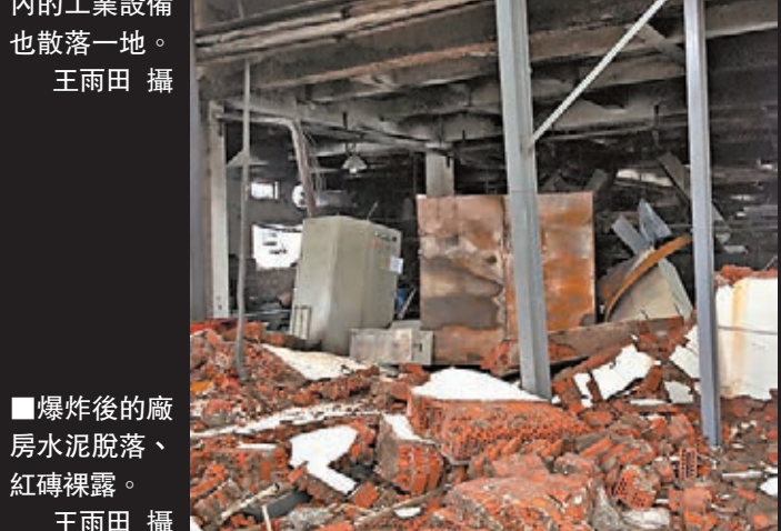
爆炸後的廠房水泥脫落，紅磚裸露。 王雨田 攝
