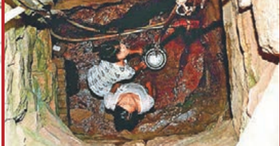
■河南旱情嚴重，村民正搶修乾旱致壞的供水泵。金月展 攝
