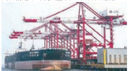
天津港遠航碼頭公司南疆26號泊位岸線長400米,寬37米,可滿足30萬噸級鐵礦石船靠泊,設計接卸能力2300萬噸/年,是港內最大的專業化礦石泊位。「萊鋼和諧」
