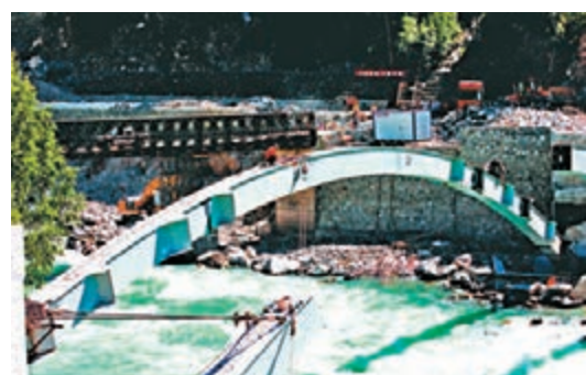
■施工中的布爾津河大橋公路。 本報新疆傳真
