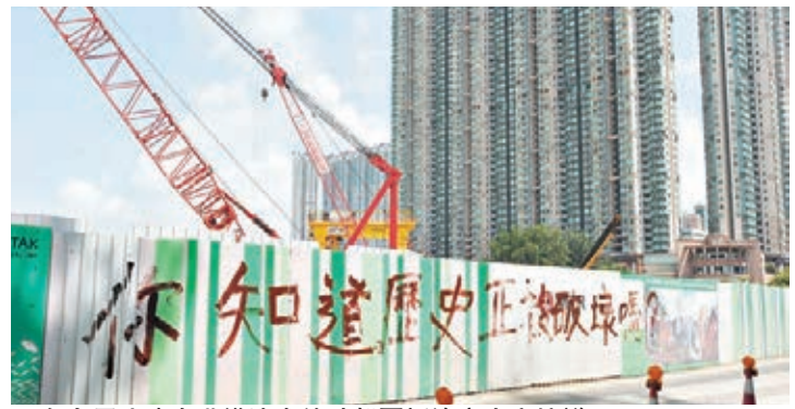
有人用油漆在港鐵沙中線地盤圍板塗寫大字抗議。
