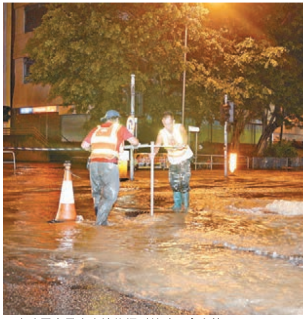
水務署人員全力搶修爆裂的地下食水管。
