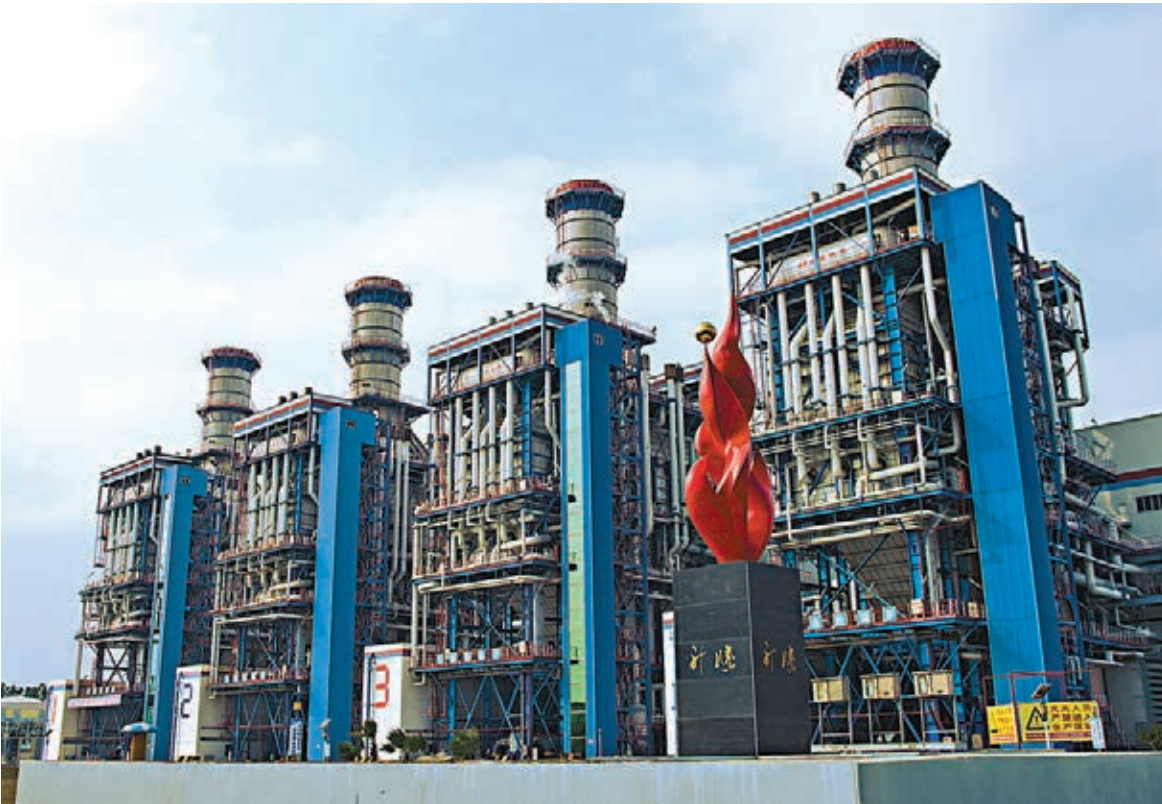
■市傳中石油將逾200億元資產，注入旗下昆侖能源。圖為燃氣電廠。
