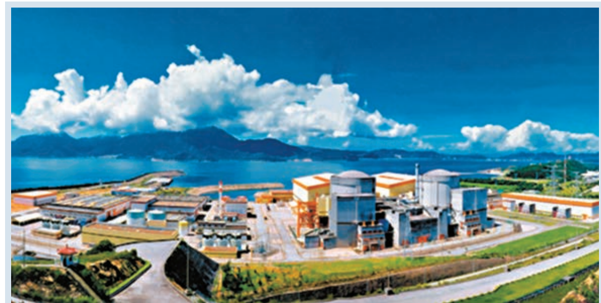
廣東大亞灣核電站是中國第一座大型商用核電站。
