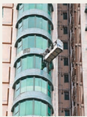
兩艘吊船被風吹到移位，消防到場營救被困工人。
