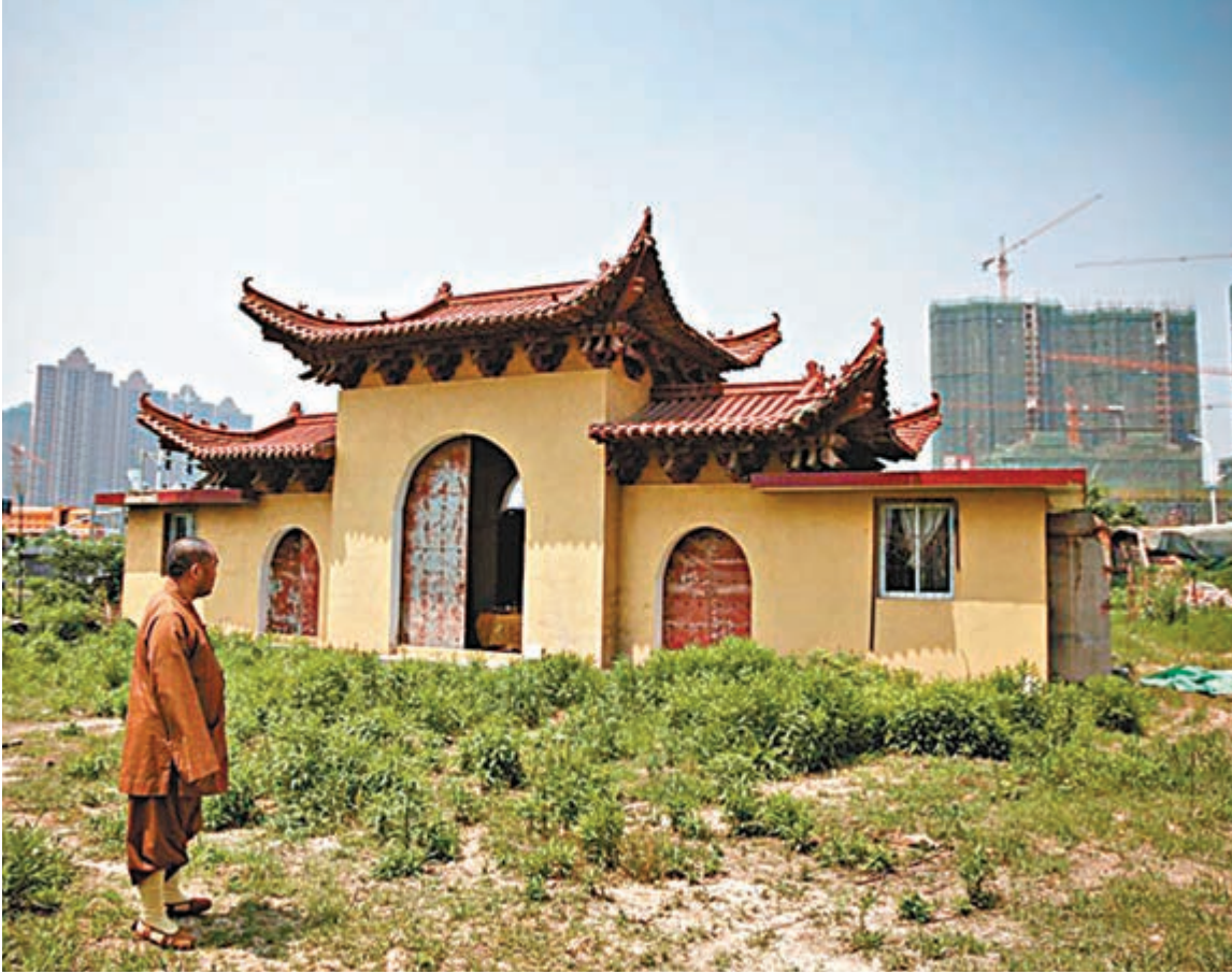
■位於江西南昌市西湖區的十里古寺，被拆除後只剩下一個山門，寺廟周圍已建滿高樓大廈。 網上圖片
