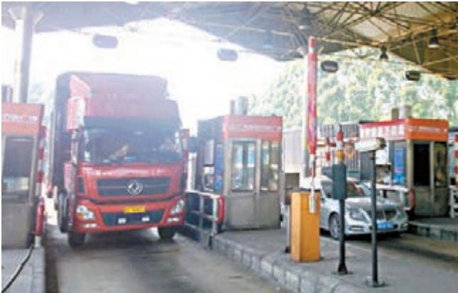
■越秀交通收費站已新裝設備，為實施貨車計重收費做準備。
