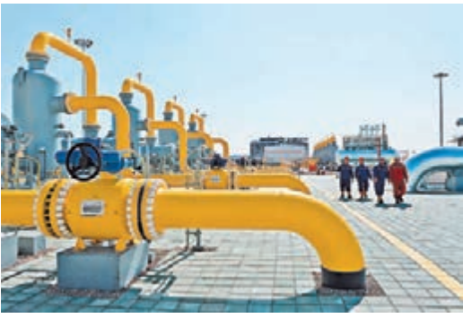
■圖為中亞管道C線天然氣到達新疆霍爾果斯計量站，工人正在進行檢查巡視工作。
