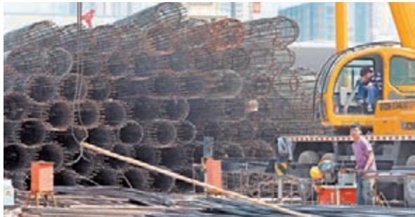
■鋼鐵行業在上海公布的清單中列限制類。圖為工人正在焊接鋼結構架。
