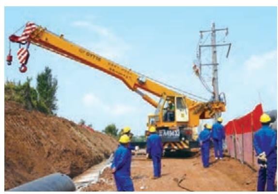
■施工人員正在現場吊裝巨大的輸水管。
