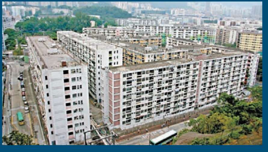
▼李兆基擬捐出的石硤尾地皮,乃大坑西邨現址。
