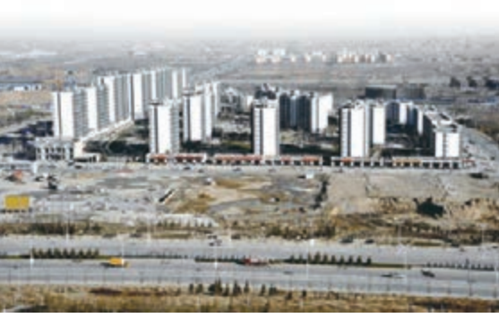
■蘭州新區綜合保稅區正在建設，建成後將成為西北地方對外開放優勢最全面的綜合保稅區。
