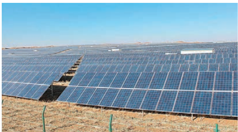
寧夏中衛慶陽100MW光伏發電項目
