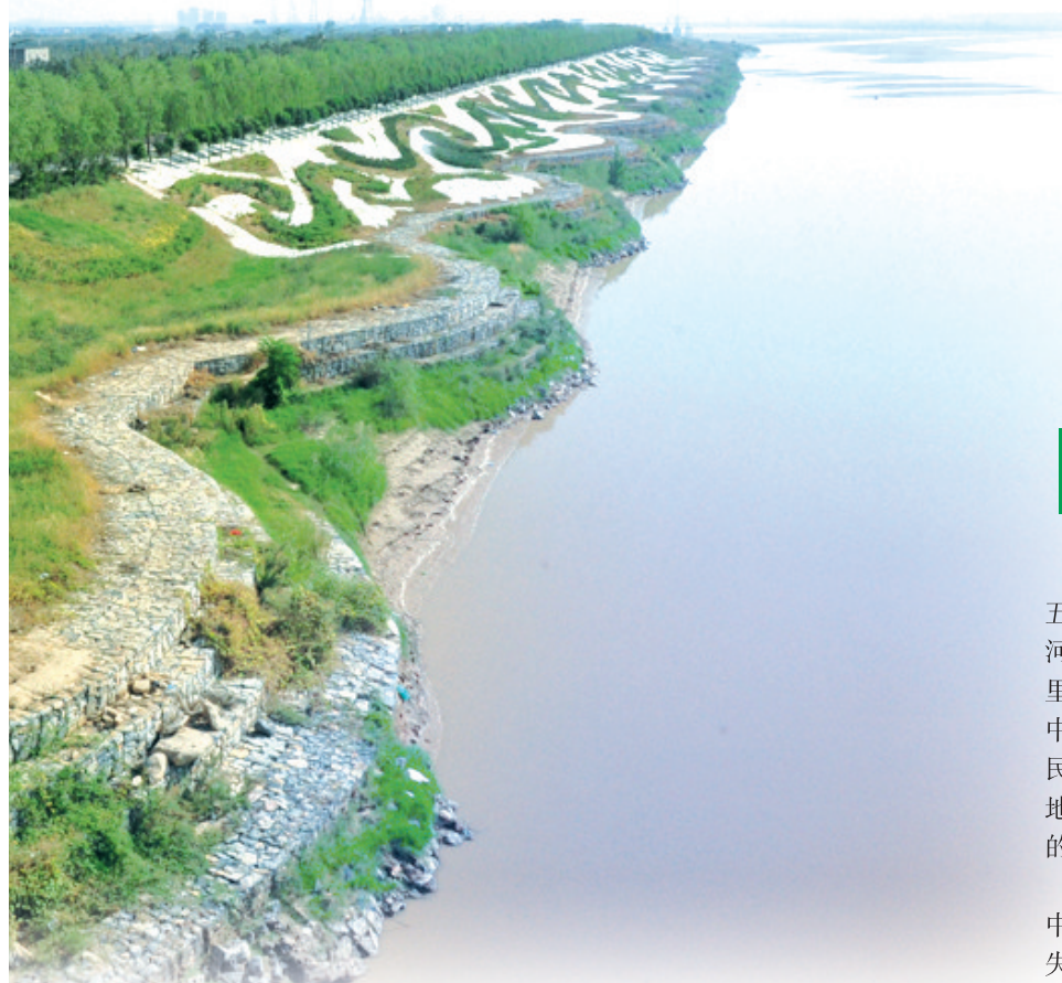
■渭河西咸新區秦漢新城段綜合治理工程。
