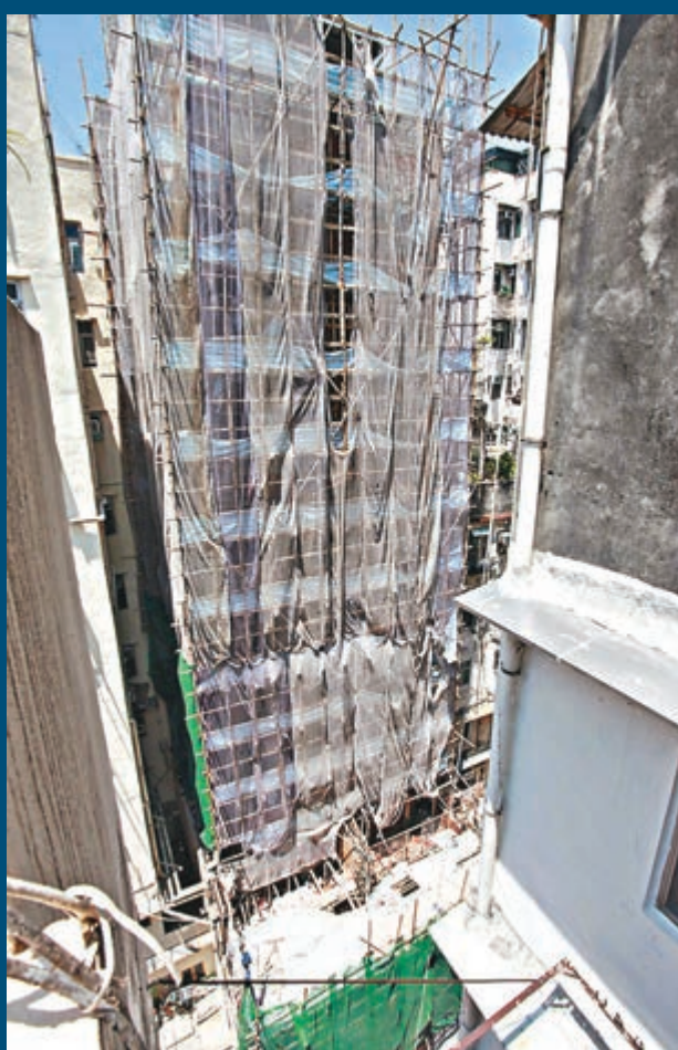
■發生男女手牽手跳樓大廈外牆正進行翻新工程。
