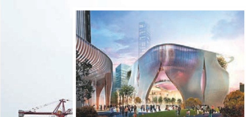
■高鐵路過西九戲曲中心工程進度。
