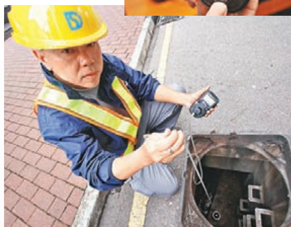
每名工人獲分發一部試氣機,可在落渠工作前測試清楚渠道內有毒或爆炸氣體。
