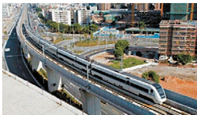
廣珠城際軌道已開通運營。
