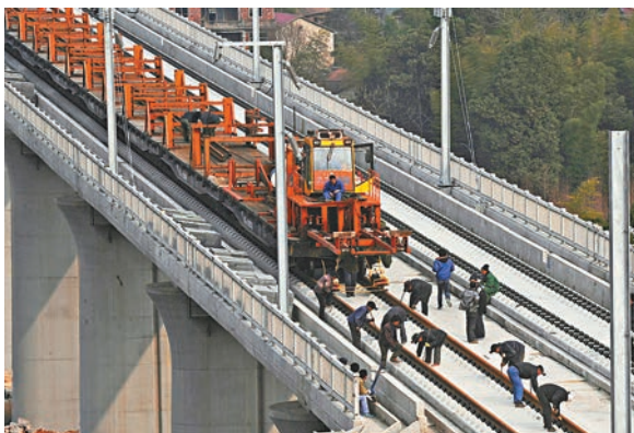
■杭長高鐵浙江段1月底全線完成鋪軌施工。資料圖片
