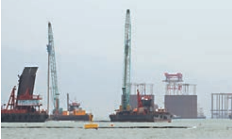
■較早前港珠澳大橋香港口岸人工島施工現場。
