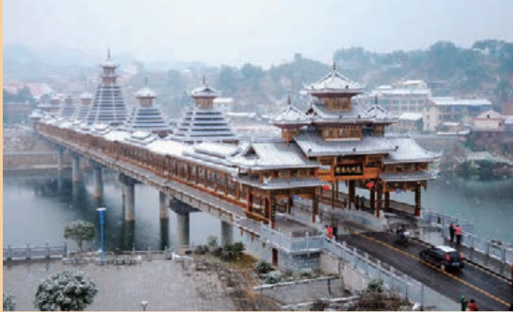
▲風雨橋是侗族獨有的橋，由橋、塔、亭組成。全用木料築成，橋面鋪板，兩旁設欄杆、長凳，橋頂蓋瓦，形成長廊式走道。塔、亭建在石橋墩上，有多層，簷角飛翹，頂有寶葫蘆等裝飾，被稱為世界十大最不可思議橋樑之一。因為行人過往能躲避風雨，故名風雨橋。圖為新晃縣風雨橋。 彭雲龍 攝
