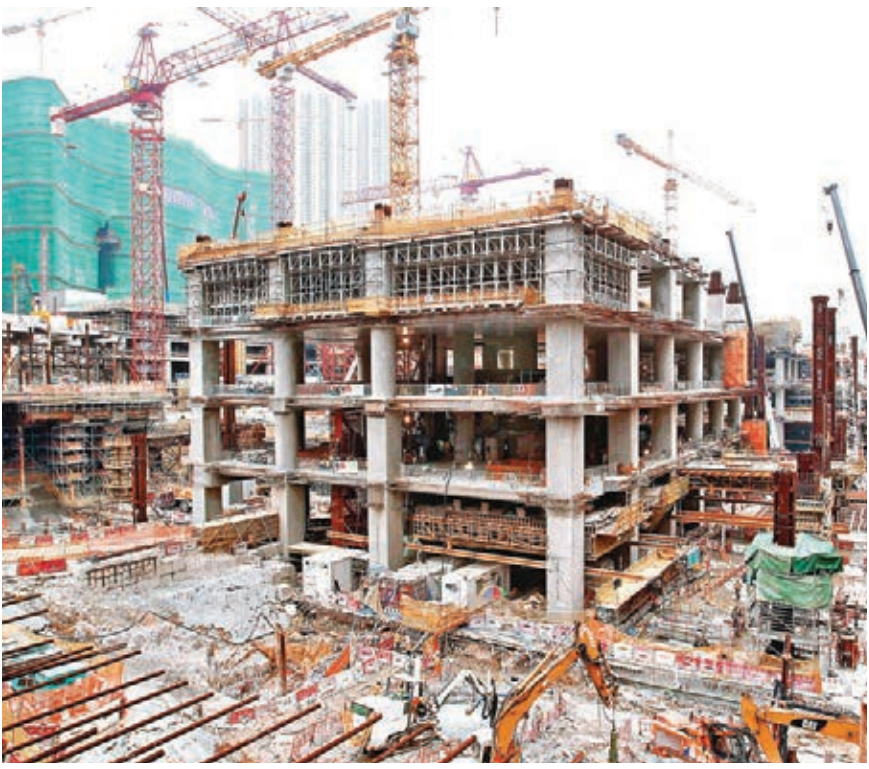
現場所見，高鐵路西九龍總站地盤最下層，有部分位置仍有石層。劉國權攝
