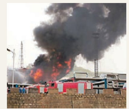
陝西延安煉油廠三個輕質油儲存罐發生閃爆着火事故,造成3人燒傷。新華社
