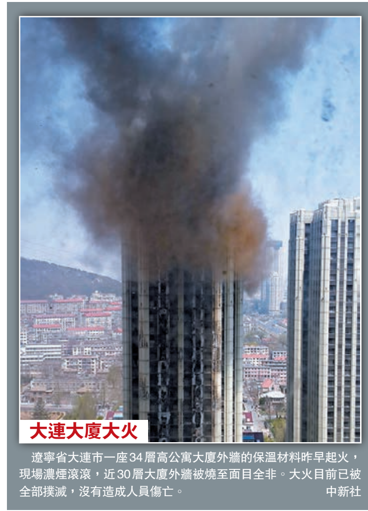
大連大廈大火 遼寧省大連市一座34層高公寓大廈外牆的保溫材料昨早起火，現場濃煙滾滾，近30層大廈外牆被燒至面目全非。大火目前已被全部撲滅，沒有造成人員傷亡。 中新社
